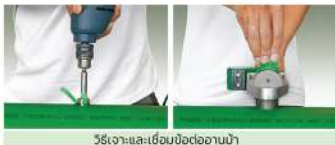
ใช้เจาะและเชื่อมข้อต่ออานม้า Weld them and then connect
